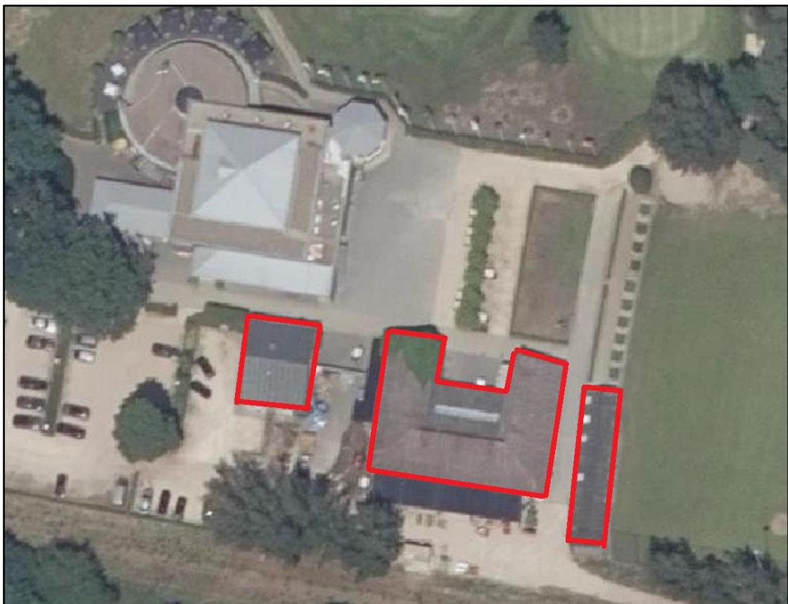
Te slopen bebouwing rood omlijnd
