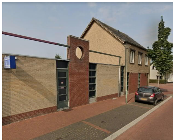
Afbeelding 9. Woning op de hoek Europalaan Centrum en Stationsweg, en deel van het magazijn van de Action, gezien vanaf de Stationsweg.
