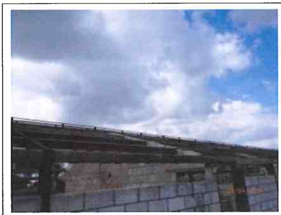
Foto 7: Gesaneerd dak en gevel stal 1
