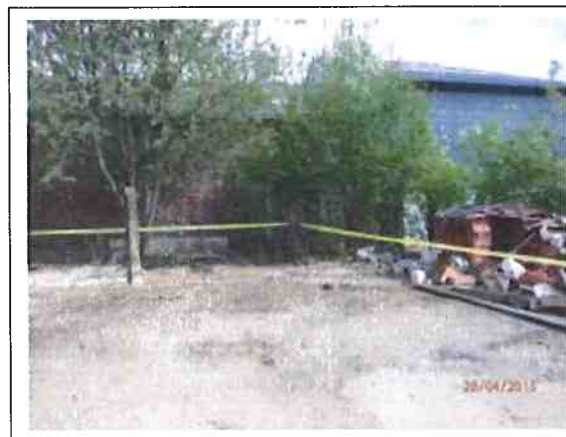
Foto 4: Plaats gesaneerde aanbouw stal 2
