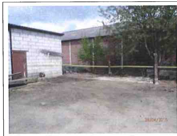
Foto 5: Plaats gesaneerde aanbouw stal 2, gehandhaafde golfplaten op opslagloods
