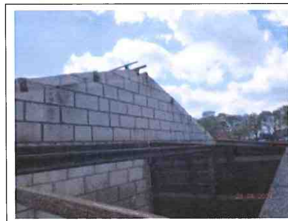
Foto 12: Gesaneerd dak aanbouw stal 1
