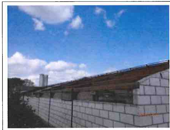
Foto 8: Gesaneerd dak en gevel stal 1
