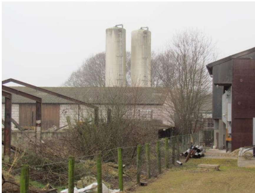
Te slopen bedrijfsbebouwing (silo's staan op buurperceel buiten planvoornemen)
