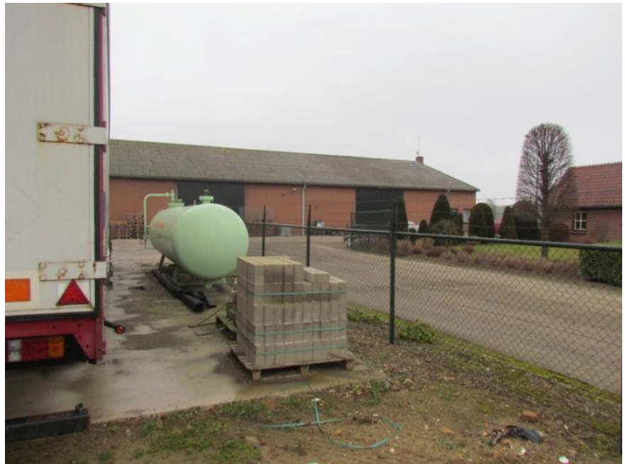
Te verplaatsen gastank
