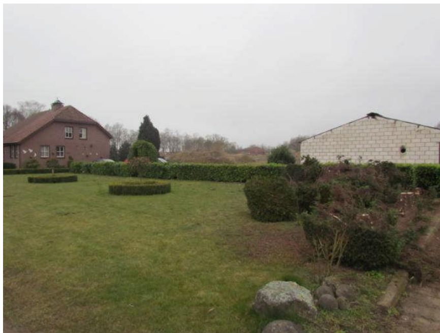
Bestaande, te slopen stal, naast te behouden woning op aangrenzend perceel
