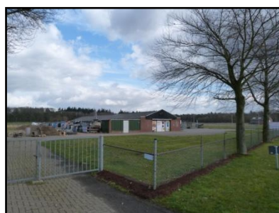
Figuur 13. Resterende voormalige bedrijfsbebouwing Herkenbosserweg 5.
