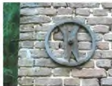
de gevel een vertanding
