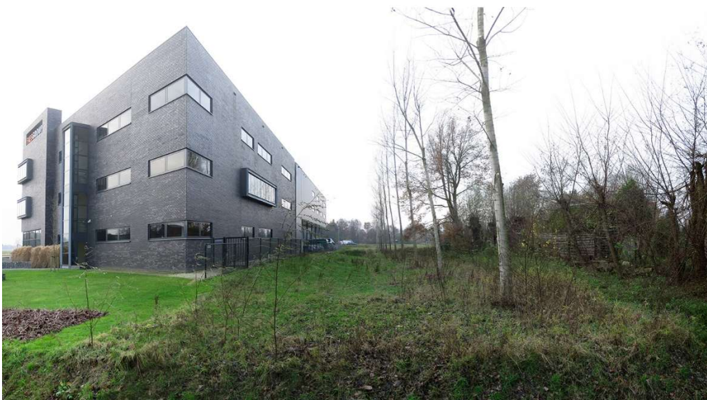
Aan de oostzijde van het plangebied ligt een bedrijf dat verpakkingen produceert en een wadi voor waterberging
