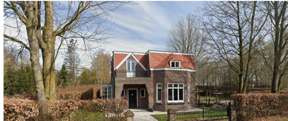
Aan de overzijde van de straat is ten noorden van De Hoeven 2 een woning uit 1932 gelegen die qua stijl aansluit bij de kombebouwing rond het plangebied.
