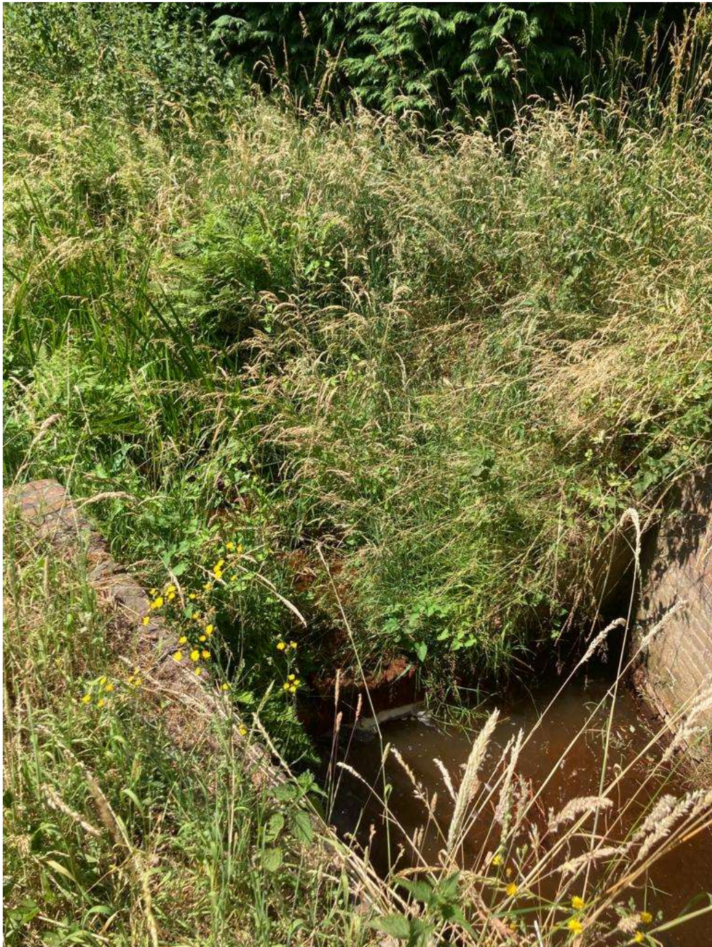
• Afbeelding 17: Waterloop/beek naast het perceel, ligt buiten het plangebied
