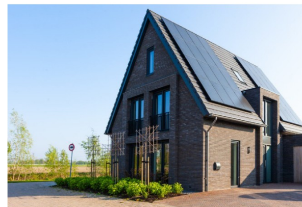
gevelopbouw, overstek dak
