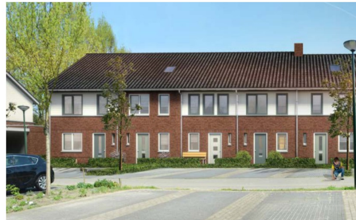
verticale gevelgeleding, accent keimwerk, kleur metselwerk
