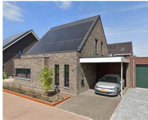
kleur metselwerk en dakpannen, kap richting
