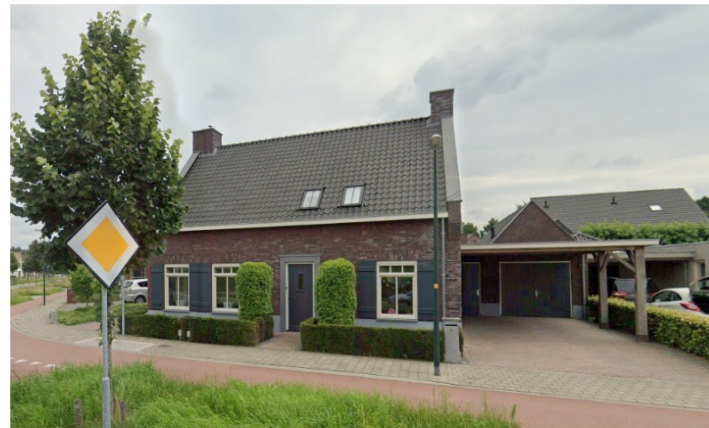
kleur metselwerk en dakpannen, doorstekende topgevel
