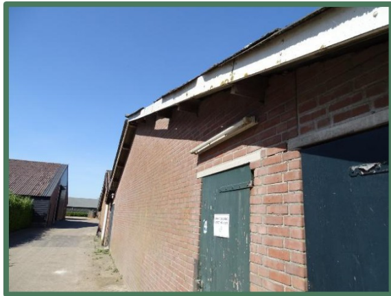
Foto 1: Overzicht gevel stal 4
