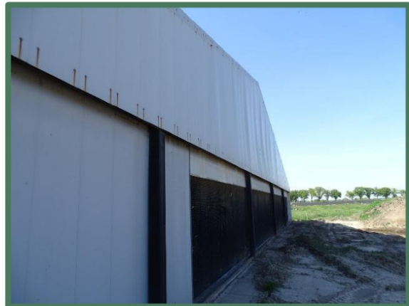
Foto 10: Overzicht gevel stal 5
