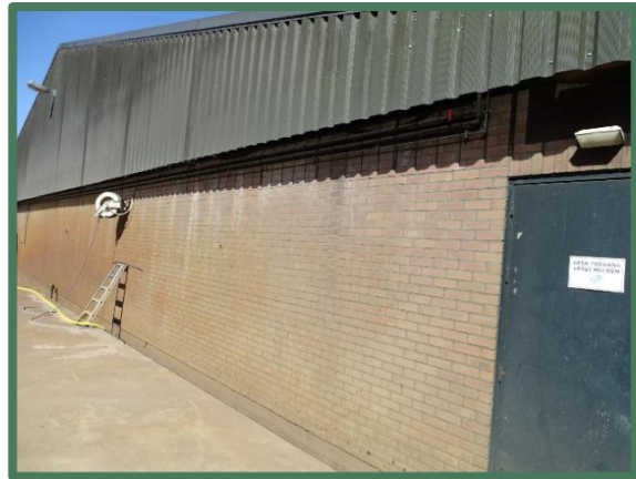
Foto 8: Overzicht gevel stal 1
