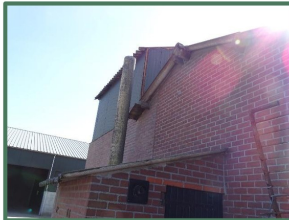
Foto 4: Overzicht gevel stal 3
