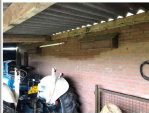
Figuur 4.4.4. Tegen de paardenstalling hangen twee steenuilenkasten.
