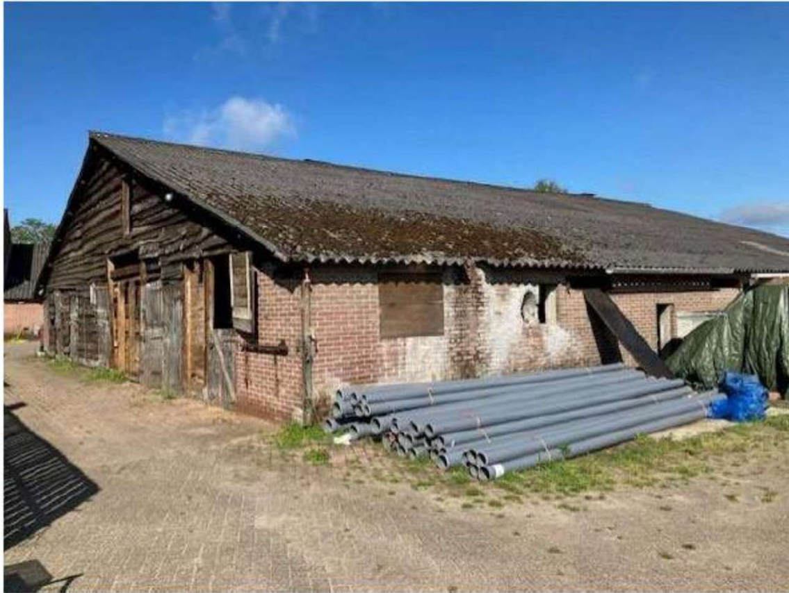
• Afbeelding 20: Te slopen varkensstal
