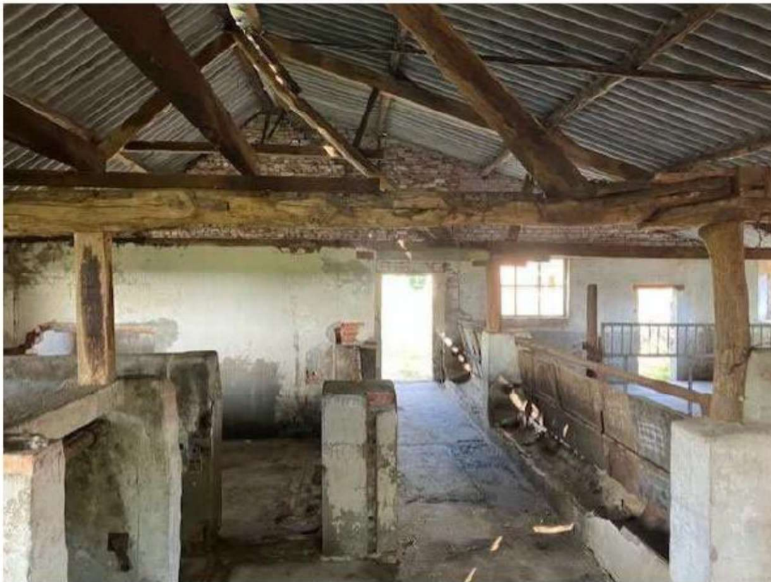
• Afbeelding 5: Binnenzijde te slopen en gestripte stal
