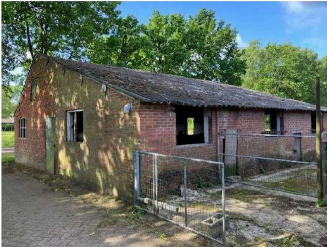
• Afbeelding 4: Te slopen varkensstal
