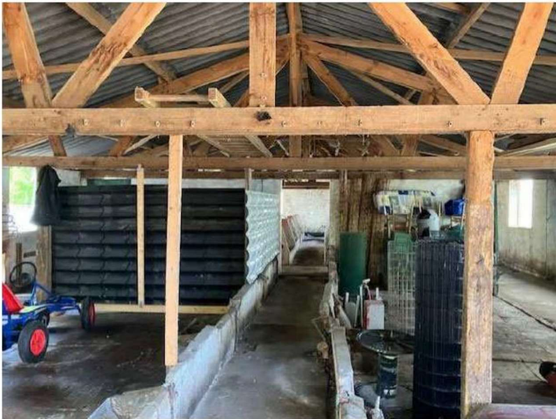
• Afbeelding 7: Binnenzijde te slopen varkensstal
