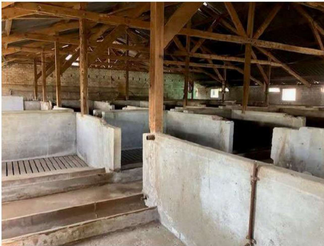
• Afbeelding 18: Te slopen varkensstal
