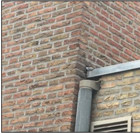
Figuur 18. Ruimte langs regenpijp die mogelijk toegang geeft tot de spouwmuur.
