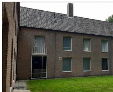
Figuur 4. Voormalig klooster, kijkrichting oostelijk.
