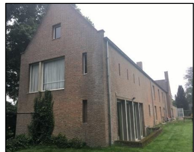
Figuur 5. Voormalig klooster, kijkrichting noordelijk.
