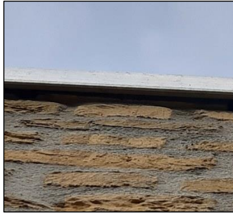
Figuur 19. Ruimte tussen daklijst en buitenmuur
