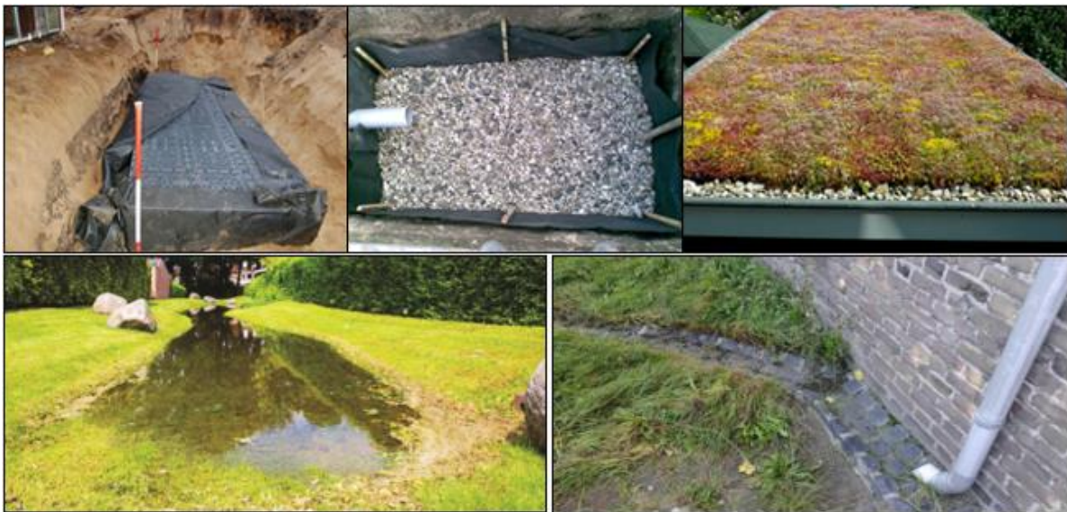
Figuur 13: Voorbeelden infiltratievoorzieningen
