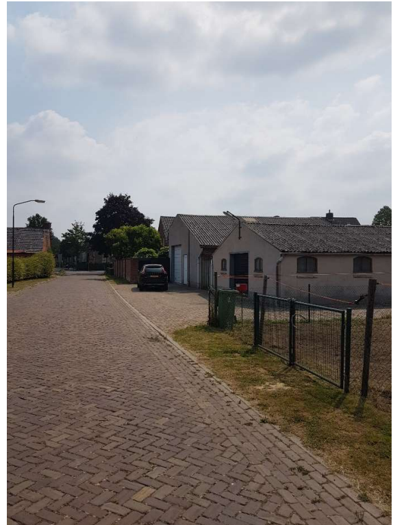
Zicht naar de Lensheuvel en de 2 te slopen gebouwen aan de rechterzijde.
