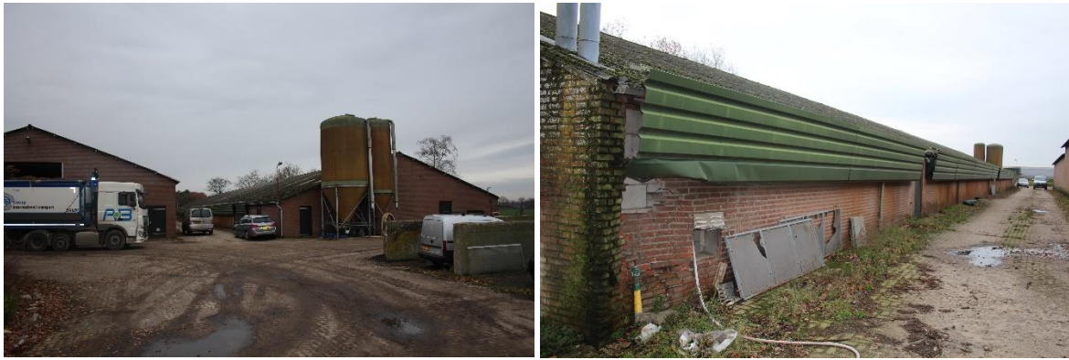
Figuur 5. Foto's van de te slopen stal Wolfsven 1 te Reusel.
