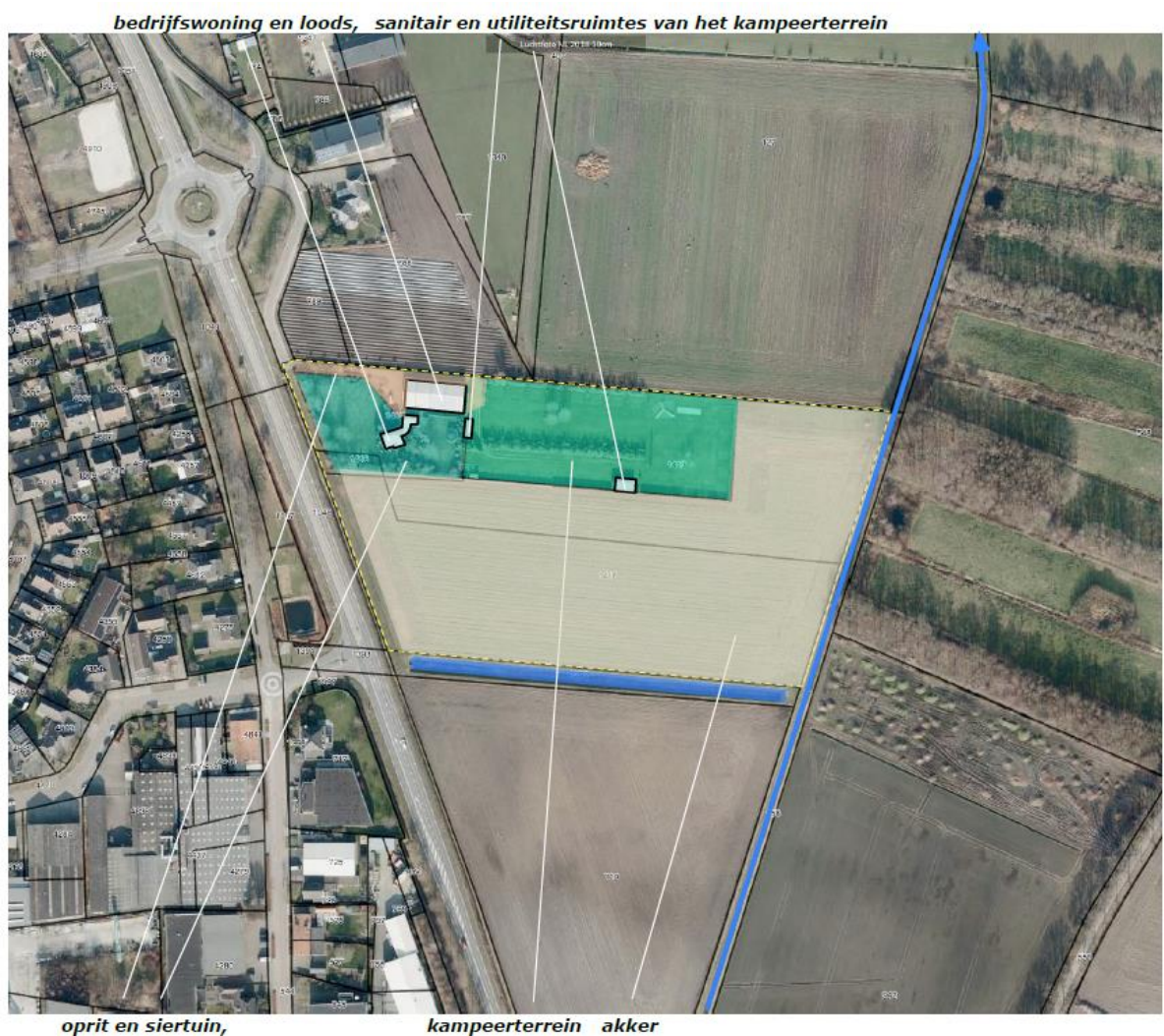
Figuur 2-2 Luchtfoto plangebied huidige gebruik Witrijt 3
