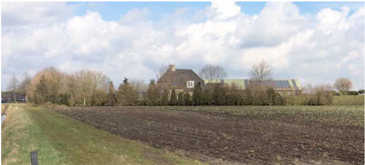
Figuur 4-4 Aanzicht bedrijfscomplex Witrijt 3
