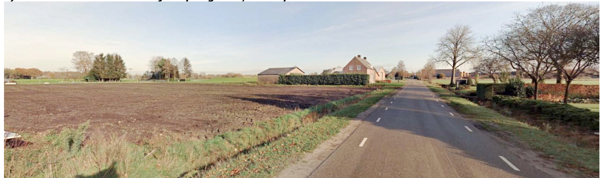
3) komend uit het westen; zicht op de westkant en de zuidkant, de woning en de haag zijn beeldbepalend
