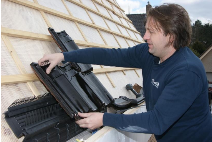
Figuur 1. Plaatsen van een mussenvide onder de nieuwe dakpannen.
