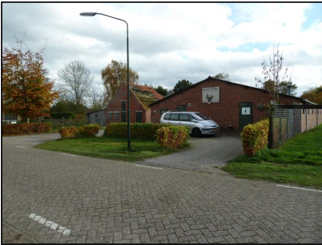
Zicht vanuit de Voort op te slopen bebouwing
