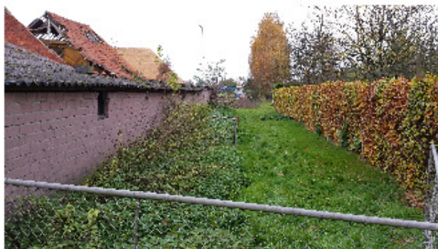
De dakconstructie van een schuur is niet intact
