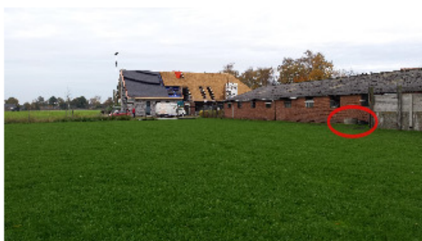
asbestverdachte drinkbak in rode cirkel
