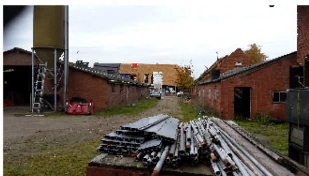
Asbestverdachte daken op alle schuren
