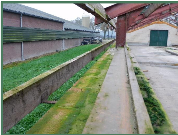
De spouw is volledig afgesloten
