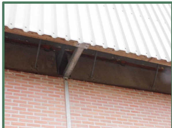
Openingen zijn dichtgemaakt met gaas
