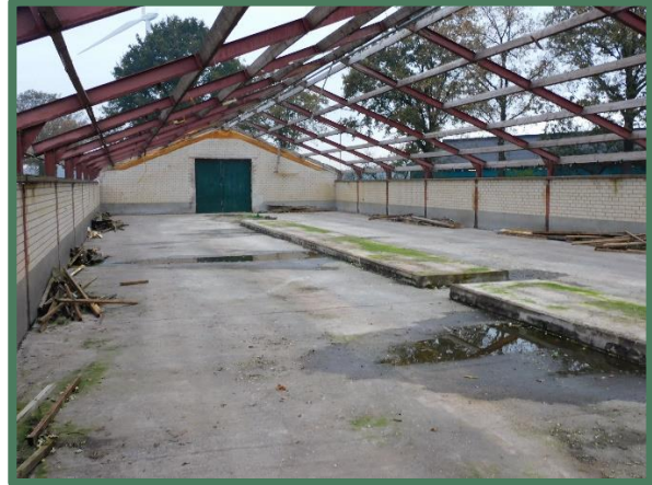
Binnenkant oude pluimveestal
