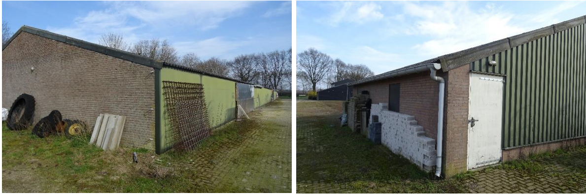
Afbeelding 3 en 4: Bestaande te slopen stallen op de kavel. Bron: R.J.L. Bijvelds 24-03-2021
