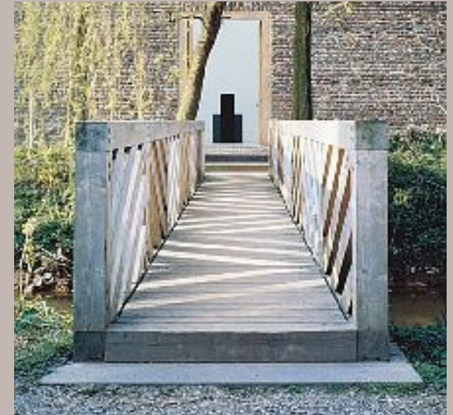
Terreininrichting en architectuur in samenhang met elkaar
