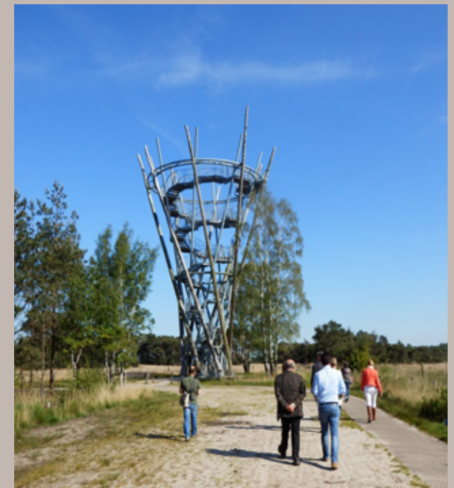
De uitkijktoren (onder) en brandtoren (boven) als 'oriëntatiepunten' op Landgoed 'De Utrecht'
