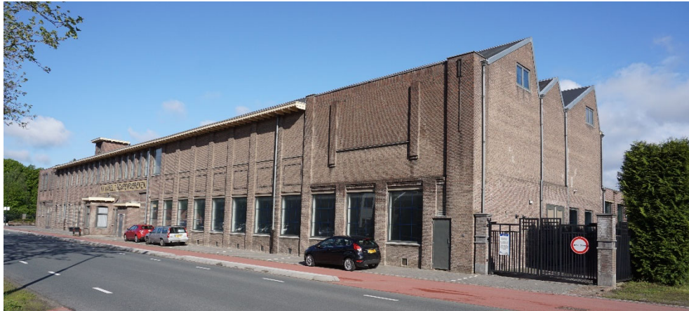
Het monumentale bedrijfspand van de voormalige Karel I sigarenfabriek: in het gedeelte rechts op de foto is op de begane grond de permanente vestiging van sportschool Training Unit voorzien.
