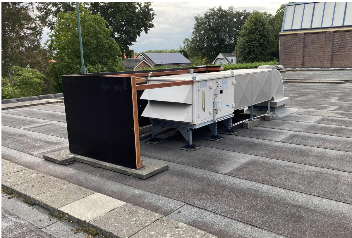
Figuur 10: Positie geluidscherm luchtbehandelingskast
