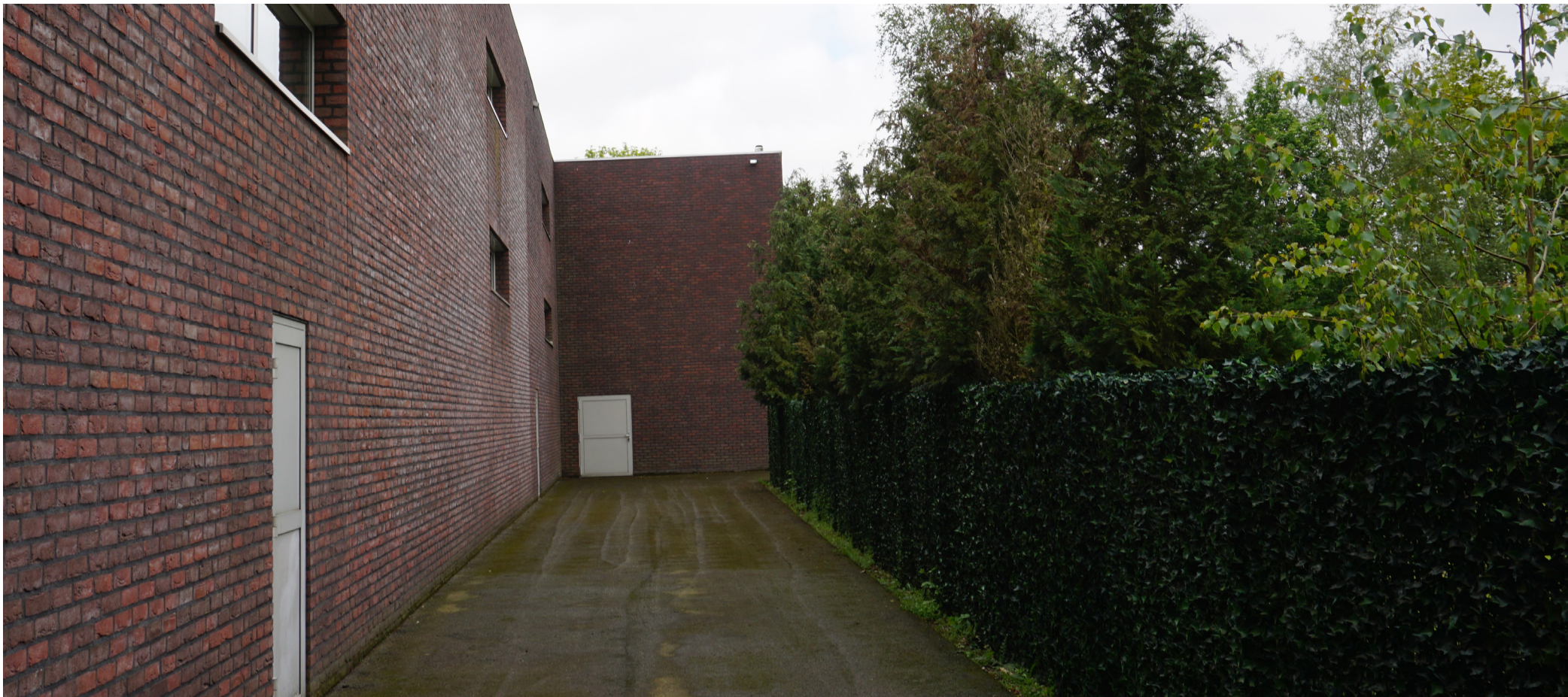
Bestaande situatie zone 2 beplantingsplan, westelijk van de bedrijfsbebouwing aan de noordwestzijde van het terrein van Turnhoutseweg 22
