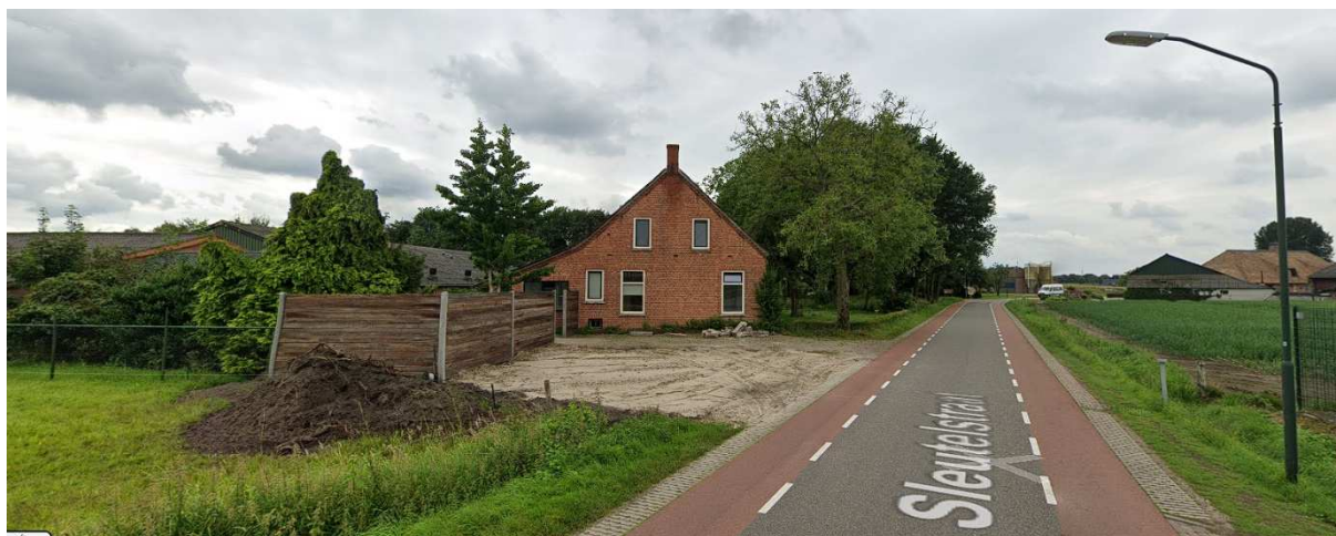
Afbeelding 1: Straatbeeld - Sleutelstraat te Reusel (Bron: Google Streetview)
