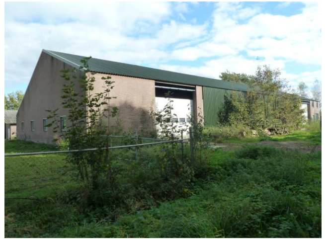
Te behouden bedrijfsgebouw.
