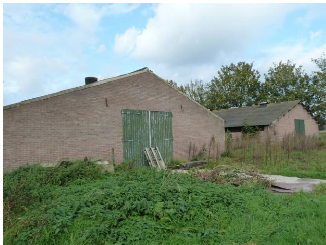
Te slopen pluimveestallen vanuit zuidelijke richting.
