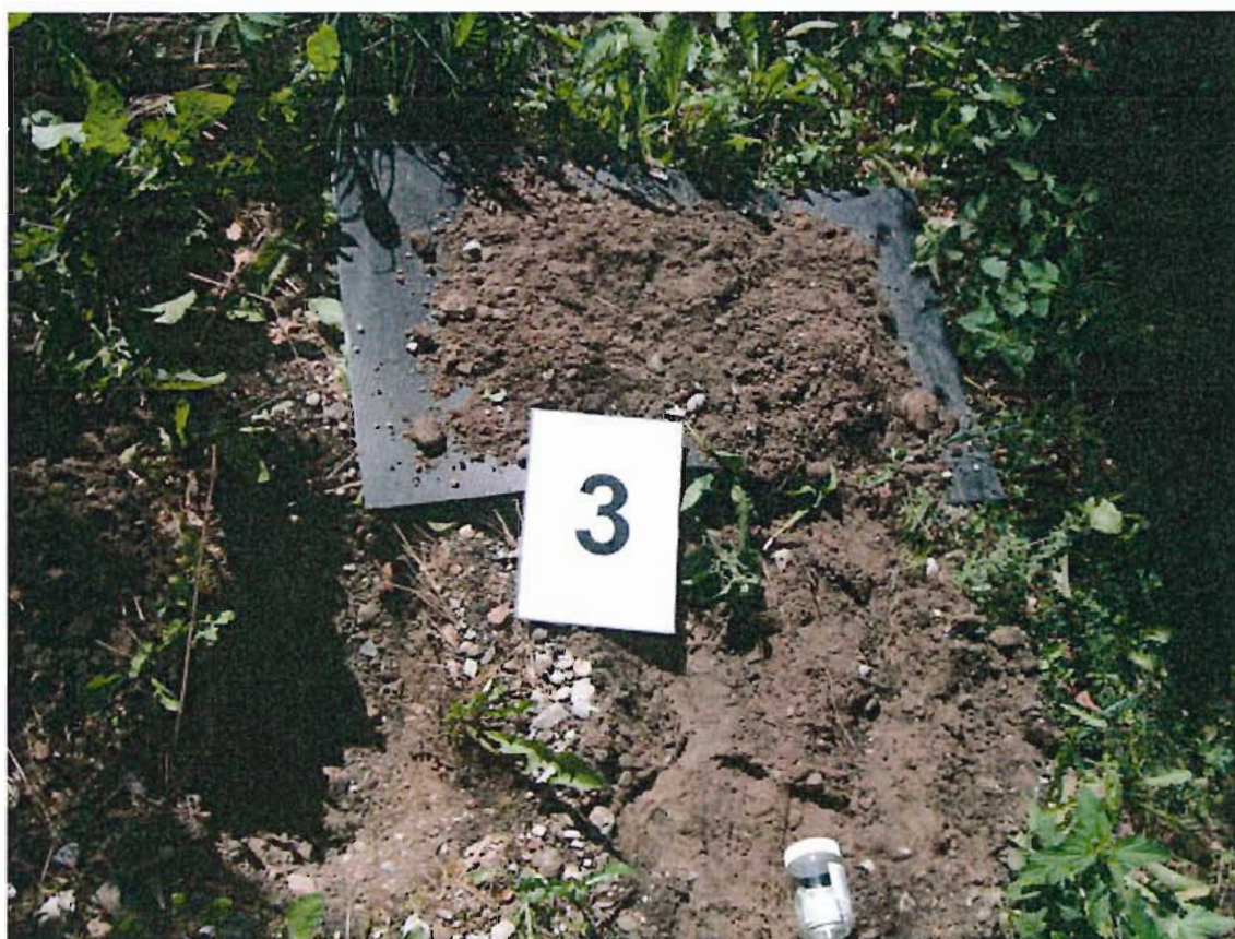
Foto 14: inspectiegat 3 met uitkomend materiaal (1 augustus 2013)
