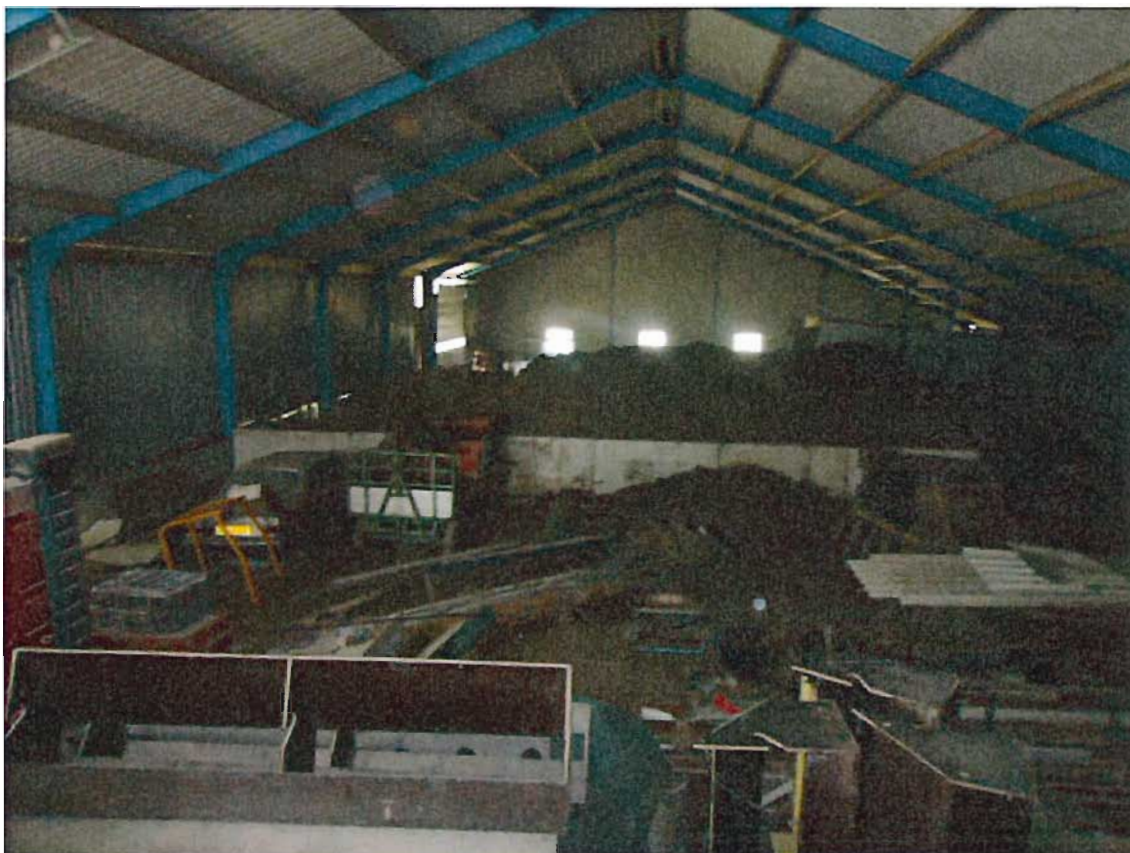
Foto 3: zuidwestelijke loods met materiaal / materieel en mestopslag (gezien vanuit het zuidoosten, 18 juli 2013)
