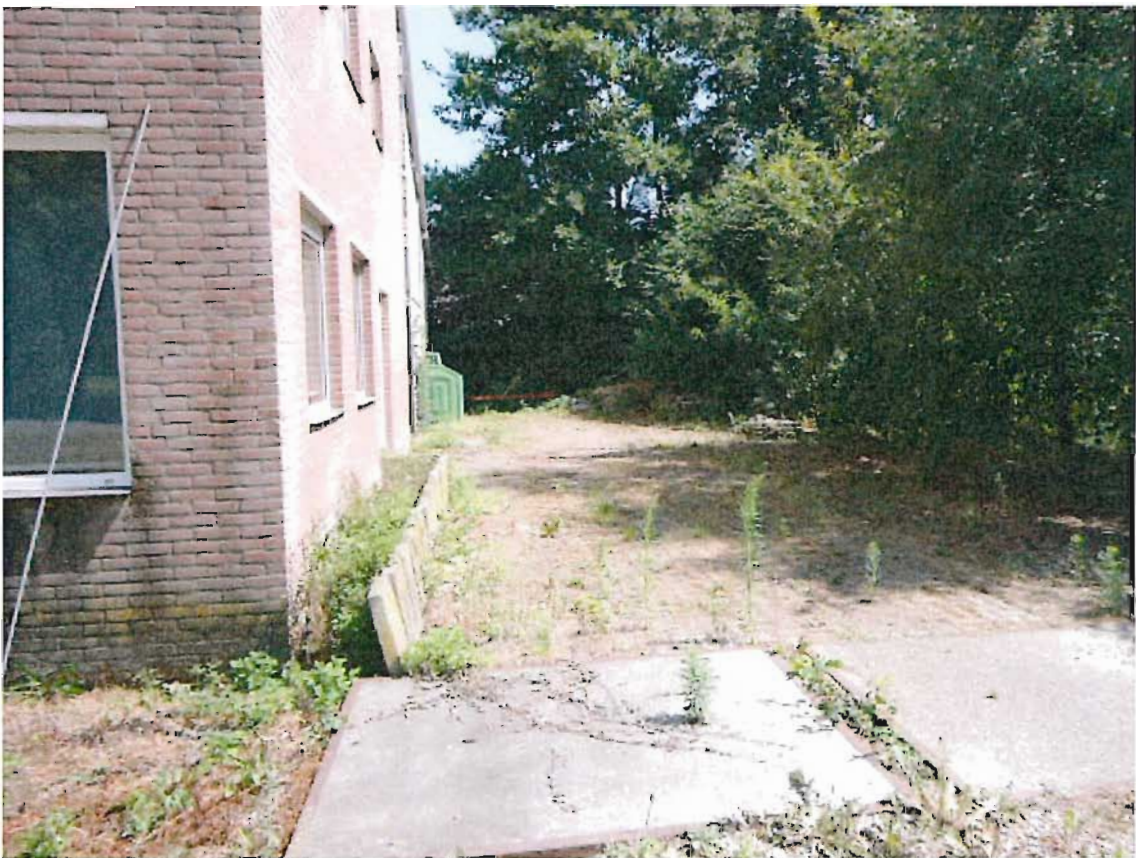
Foto 2: klinkerverharding ten zuidoosten van de opslagloods (gezien vanuit het zuidwesten, 18 juli 2013)
