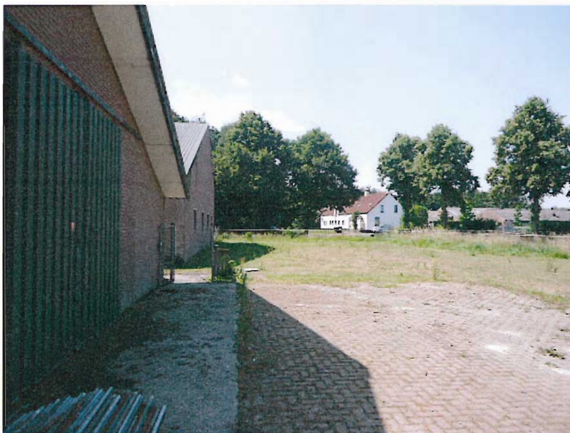
Foto 6: noordwestzijde van het bedrijfspand met een gedeelte klinkerverharding (gezien vanuit het noordoosten, 18 juli 2013)
