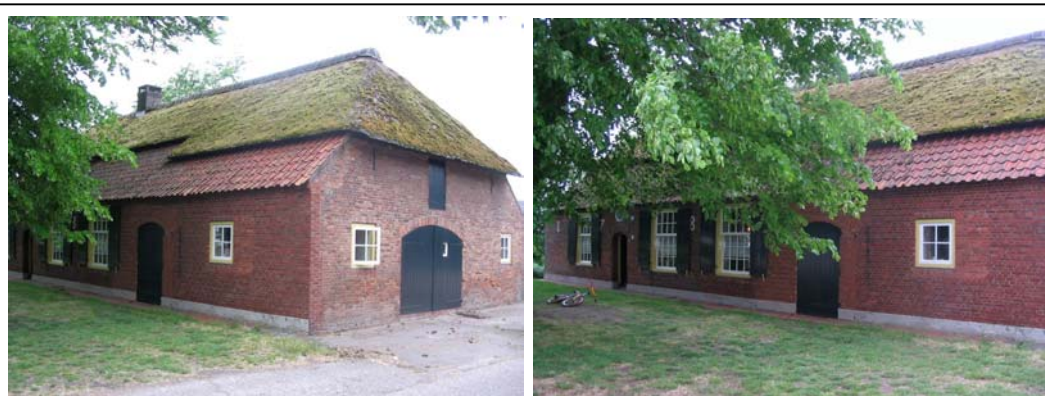
Figuur 3: foto's langgevelboerderij de Luther 15. De langgevelboerderij betreft een Rijksmonument. Dit betekent dat het een bepaalde waarde heeft voor de streek. De realisatie van de extra woning vindt intern plaats waardoor er aan de buitenzijde bijna niets verandert.
