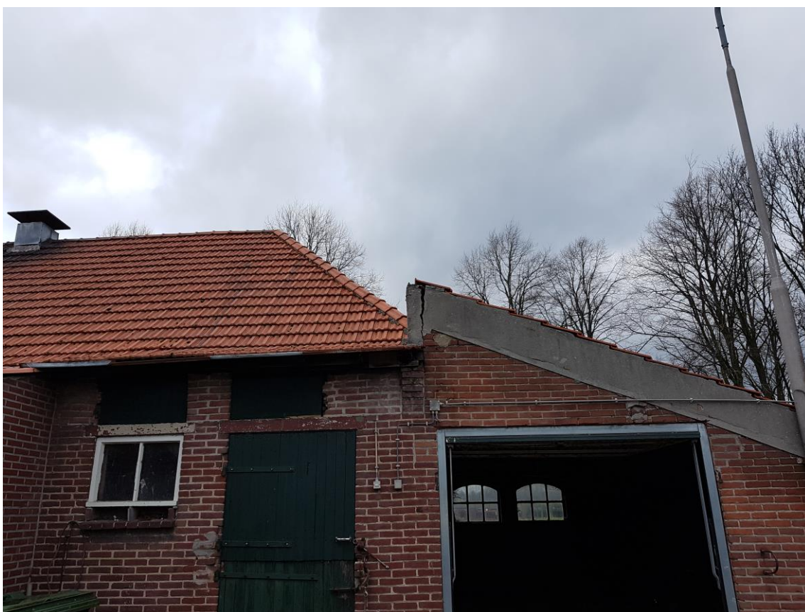
Buitenzijde te slopen woning
