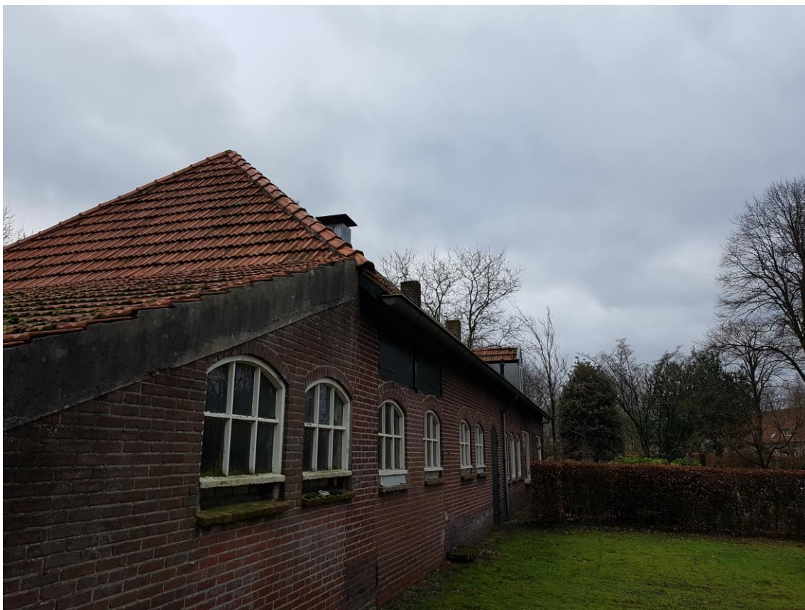
Buitenzijde te slopen woning
