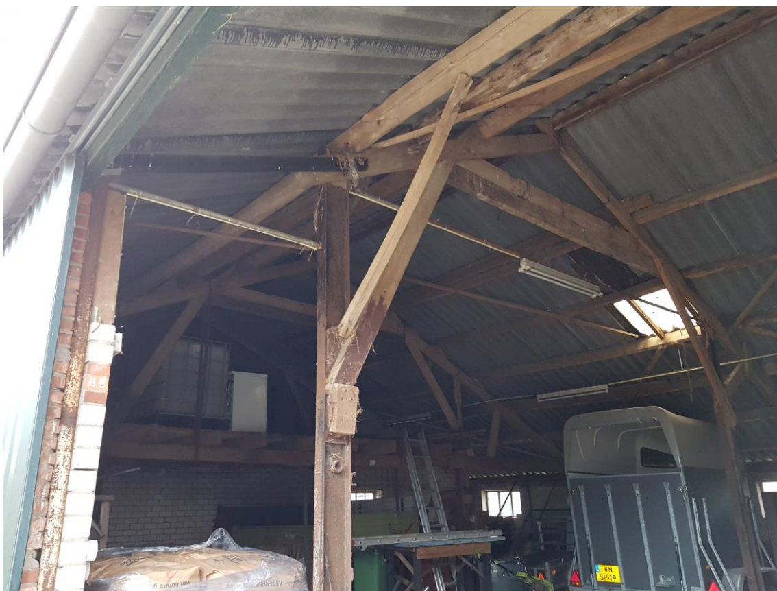
Open schuur met balken
