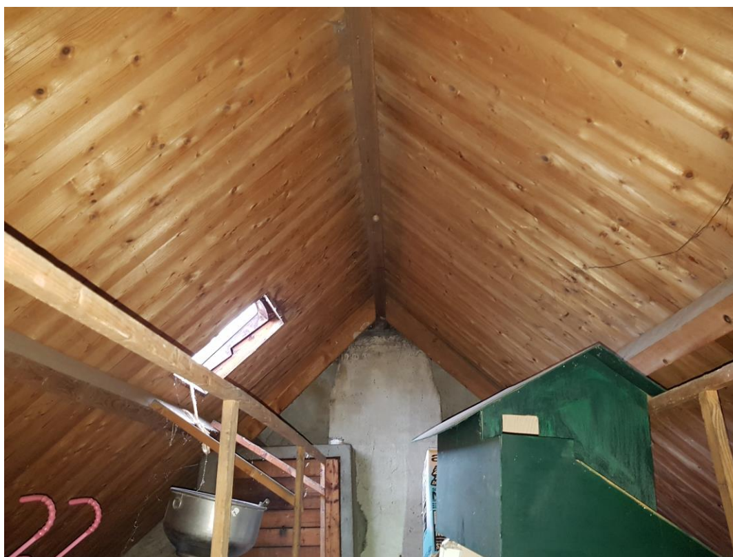
Zolder te slopen woonhuis
