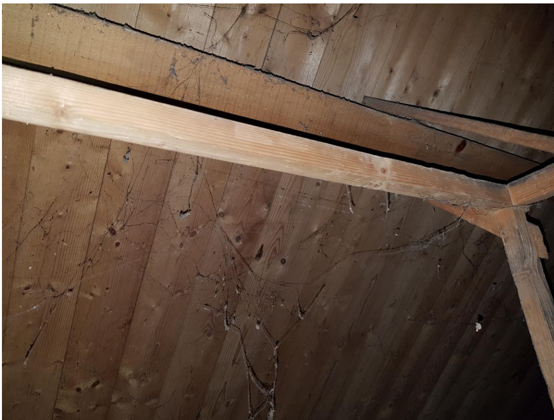
Balken op zolder te slopen woonhuis
