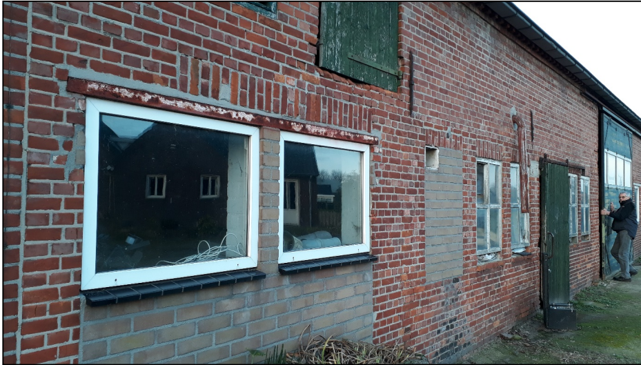
Figuur 26: Foto's van de boerderij in de huidige situatie
