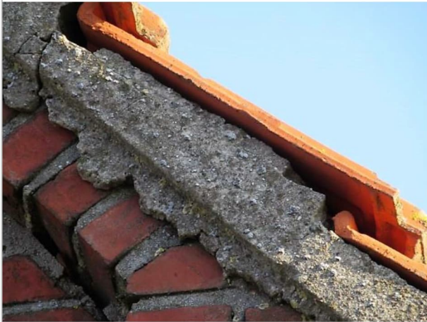
speciezoom losgetrokken gevel no. 2 (foto 2021)
