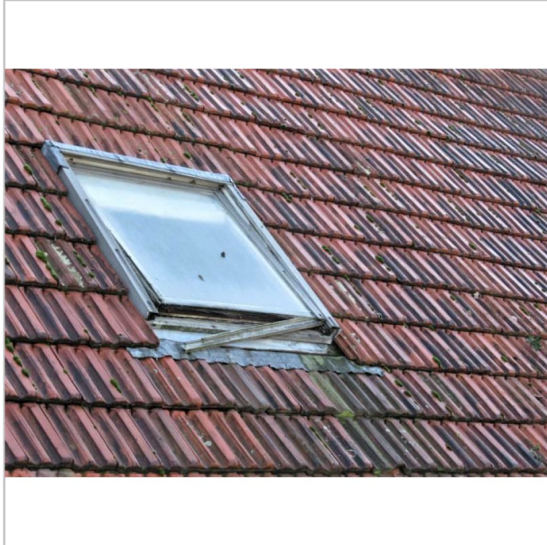
velux dakraam stuk dak no. 4 (foto 2021)
