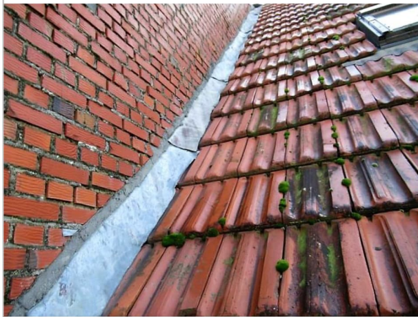
gevellood gevel no. 6 (foto 2021)
