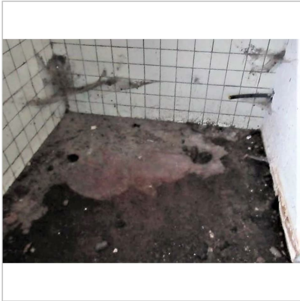
gier op de vloer van het souterrain woongedeelte (foto 2021)
