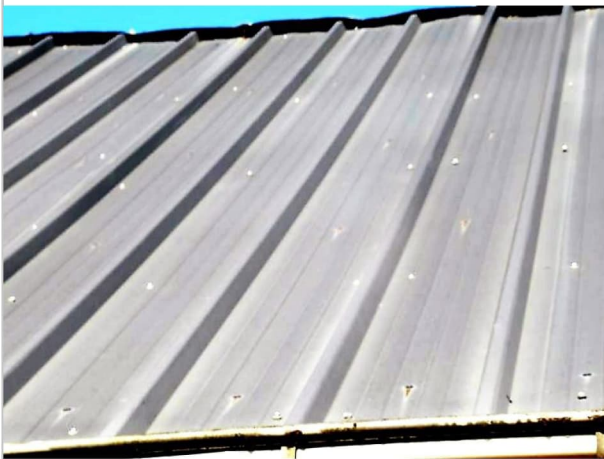
damwand dakplaten dak no. 2 (foto 2021)
