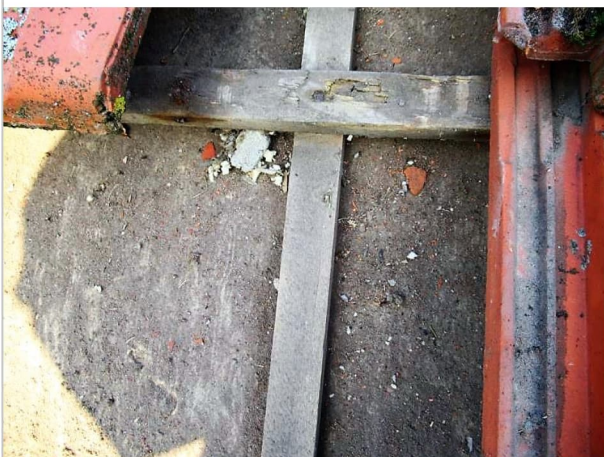
isolatie dakplaten dak no. 1 (foto 2021)
