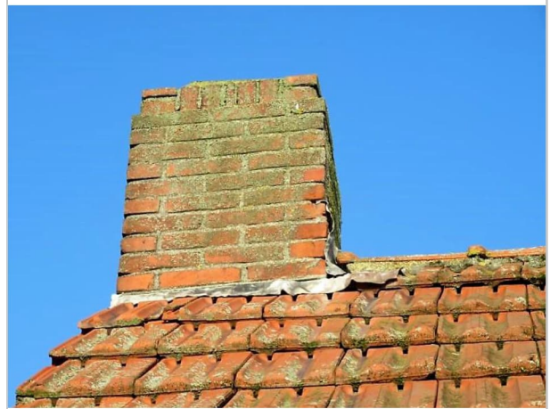
lood schoorsteen schoorsteen no. 1 (foto 2021)
