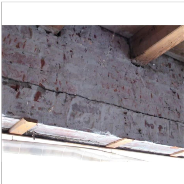
latei losgescheurd gevel no. 1, woongedeelte (foto 2021)
