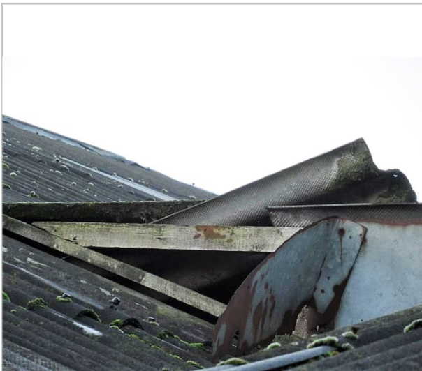
zijwang geheel stuk dak no. 5 (foto 2021)
