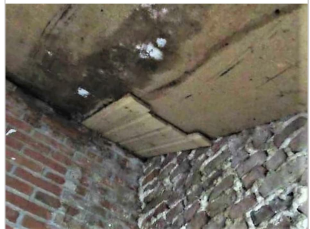
dakbeschot ingerot en deels hersteld onder dak no. 4, tegen gevel no. 2 (foto 2021)
