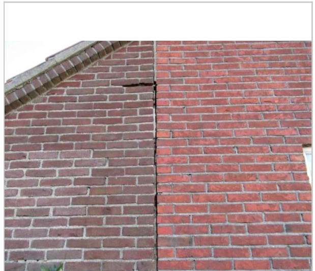
muurwerk gescheurd gevel no. 2 (foto 2021)
