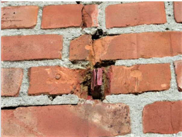
oud gevelanker afgeslepen gevel no. 1 (foto 2021)
