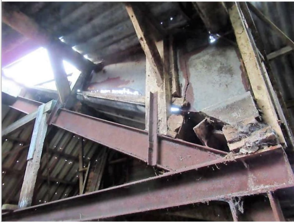
stalen spant onder dak no. 5 (foto 2021)
