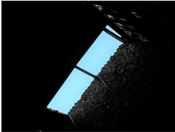
golflaten weggevallen dak no. 5 (foto 2021)
