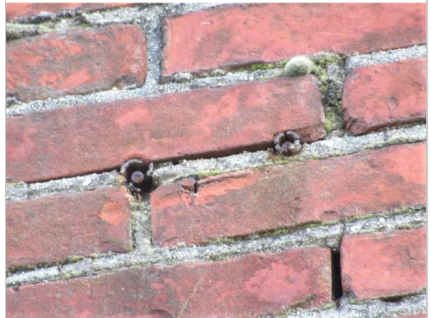
keilbouten in het muurwerk gevel no. 2 (foto 2021)
