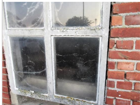
betonnen stalramen (foto 2021)
