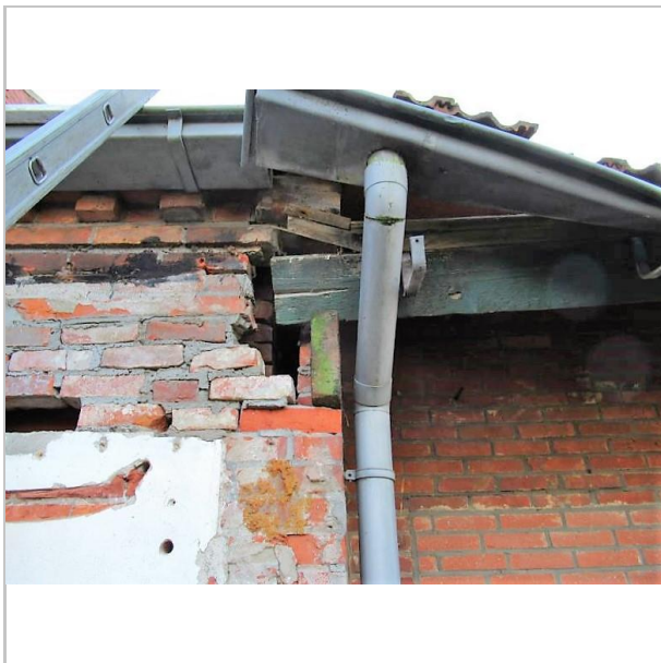
goot flink vervormd goot no. 3 (foto 2021)
