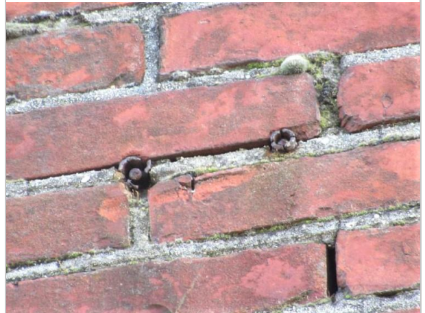
keilbouten in het muurwerk gevel no. 2 (foto 2021)
