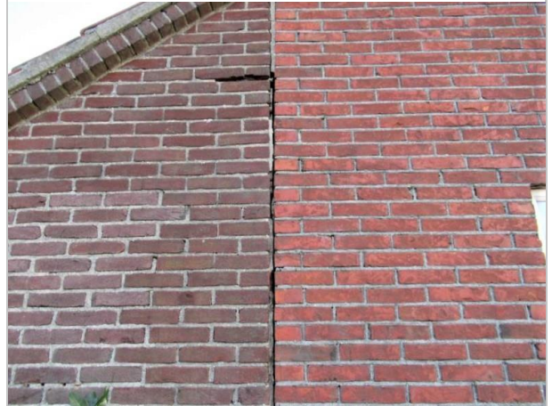
muurwerk gescheurd gevel no. 2 (foto 2021)
