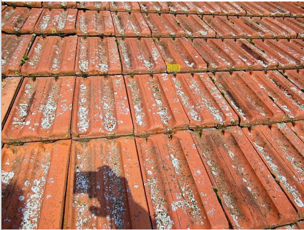
dakpannen enigszins verweerd dak no. 1 (foto 2021)
