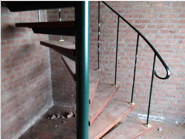
stalen spiltrap met houten treden woongedeelte (foto 2021)
