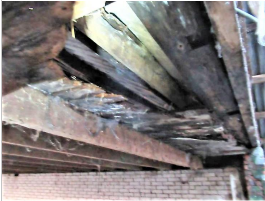
ingerotte vloerplanken stalgedeelte (foto 2021)
