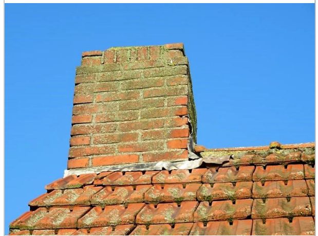
lood schoorsteen schoorsteen no. 1 (foto 2021)
