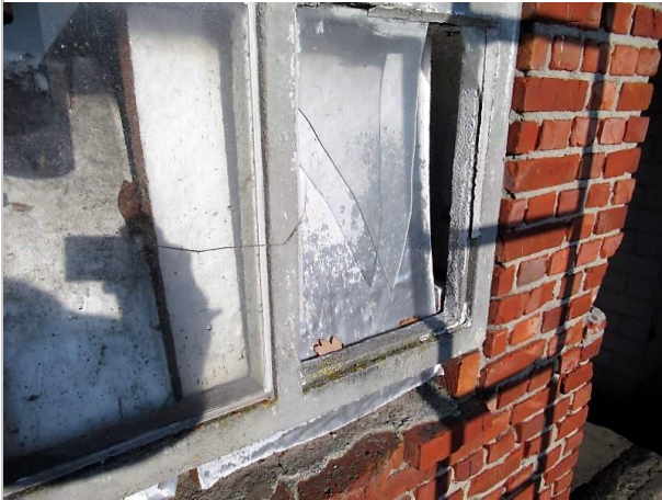
betonnen buitenraamkozijn gevel no. 1 (foto 2021)
