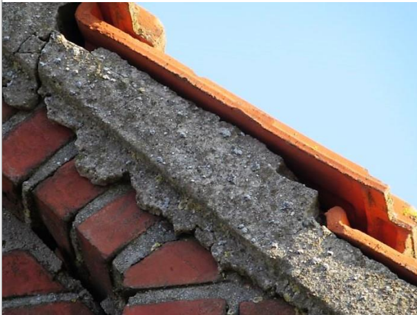
speciezoom losgetrokken gevel no. 2 (foto 2021)
