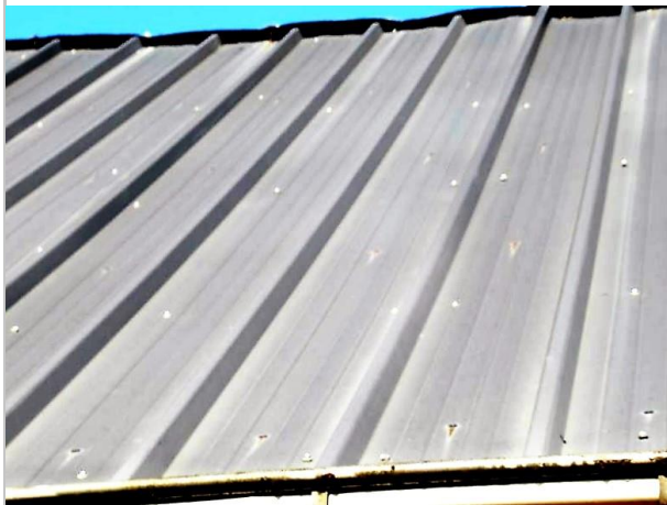
damwand dakplaten dak no. 2 (foto 2021)
