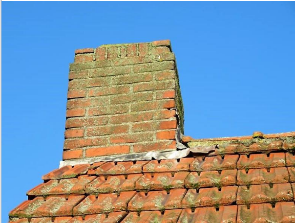
schoorsteen no. 1 (foto 2021)
