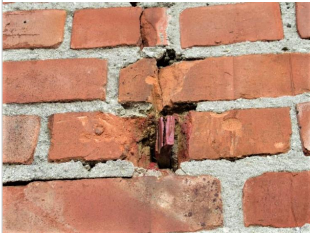
oud gevelanker afgeslepen gevel no. 1 (foto 2021)
