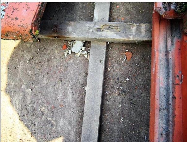
isolatie dakplaten dak no. 1 (foto 2021)
