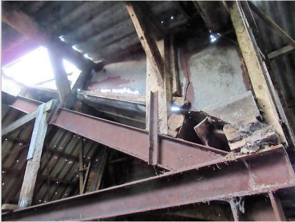
stalen spant onder dak no. 5 (foto 2021)
