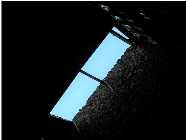
golflaten weggevallen dak no. 5 (foto 2021)
