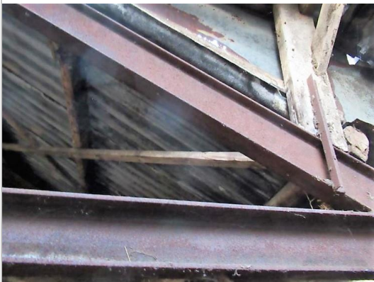
stalen spanten in het stalgedeelte (foto 2021)
