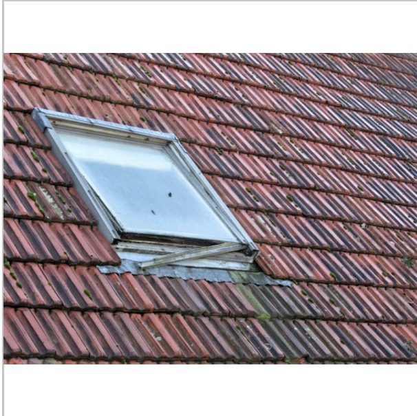
velux dakraam stuk dak no. 4 (foto 2021)
