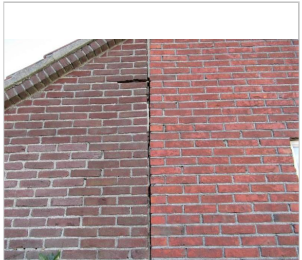
muurwerk gescheurd gevel no. 2 (foto 2021)
