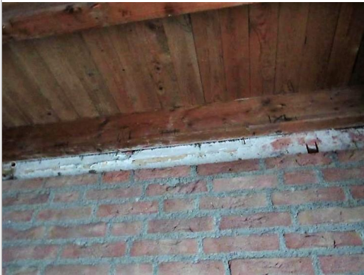
woongedeelte binnenwand aangebracht (foto 2021)
