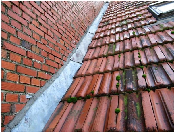
gevellood gevel no. 6 (foto 2021)
