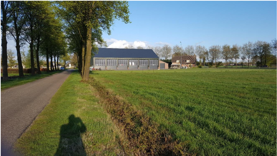
Figuur 2-10 Aanzicht op de loods aan de Voort 32 vanaf de Bakmannen op ongeveer 50 meter afstand
