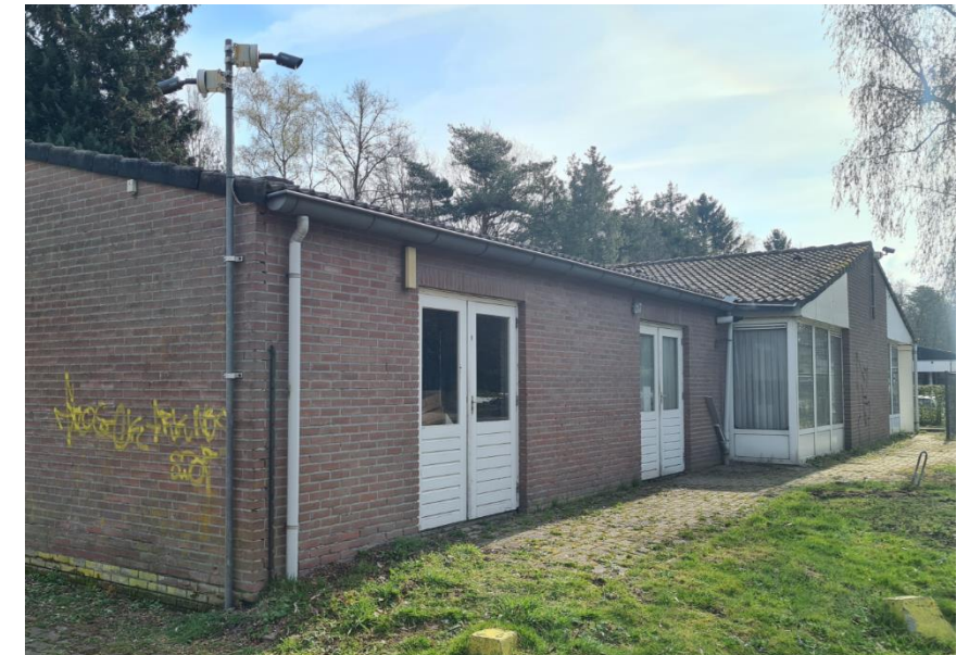
Figuur 4: Te slopen entreegebouw
