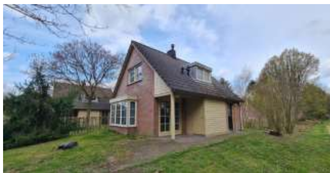
Figuur 8: Te behouden stenen woningen in noordwesten gebied
