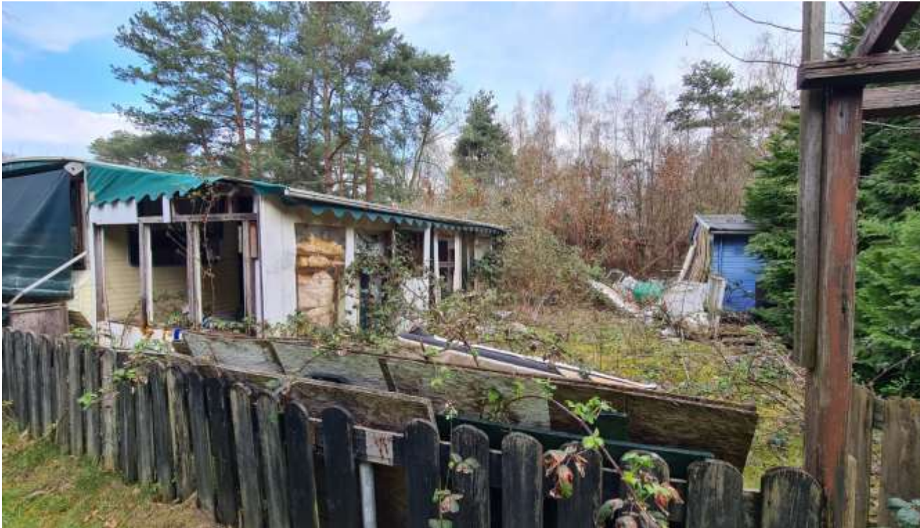
Figuur 4: Verlaten stacaravan in het westen van het plangebied
