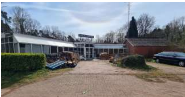
Figuur 7: gebouw voormalig café-restaurant
