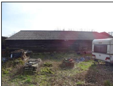
Figuur 3. (Te renoveren) schuur op de onderzoekslocatie.
