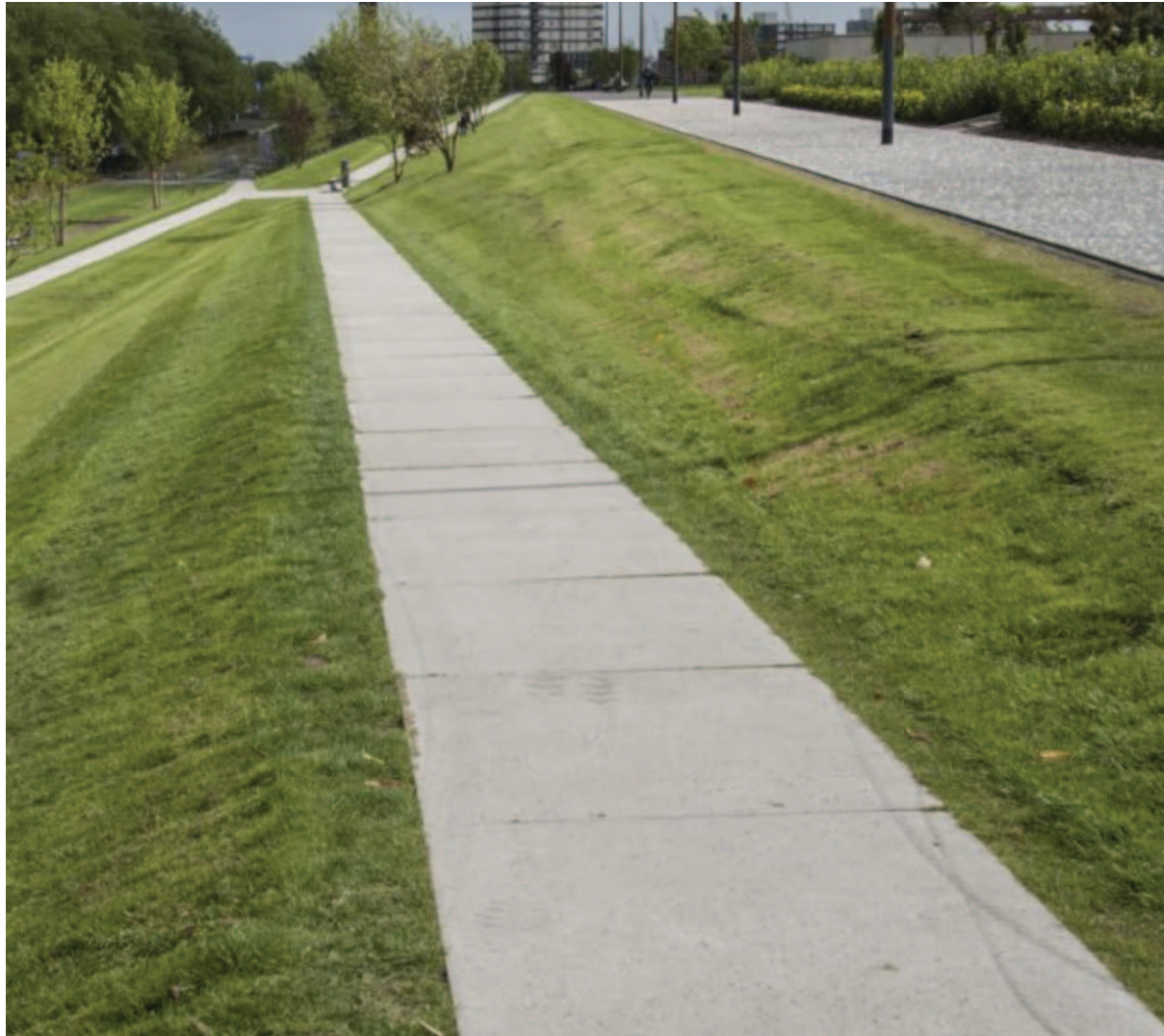
fietsers en voetgangers vanaf de dijk
