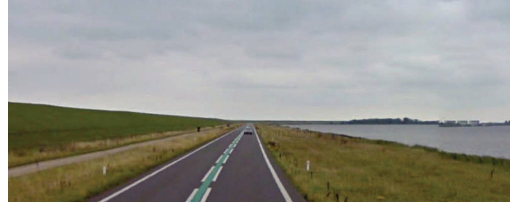
2. Zicht vanaf de N361 vanuit Friesland
