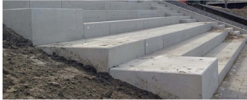
sluisplein van robuuste betonelementen
