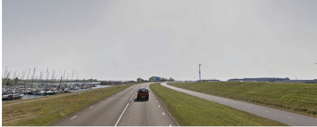
1. Zicht vanaf de N361 vanuit Groningen
