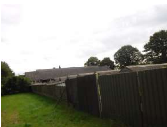
Locatie volledig omheind met golfplaten, gedeeltelijk ingegraven.
