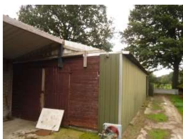
Aanbouw achter aan loods.
