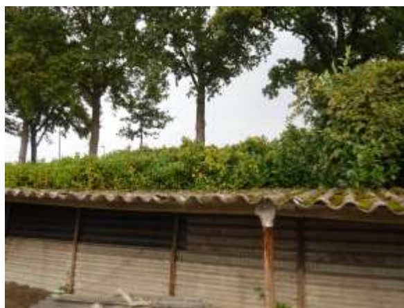
Afdak tegen de omheining.
