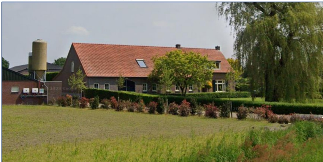
Woning Karstraat 6 (bron: Google, 2023)
