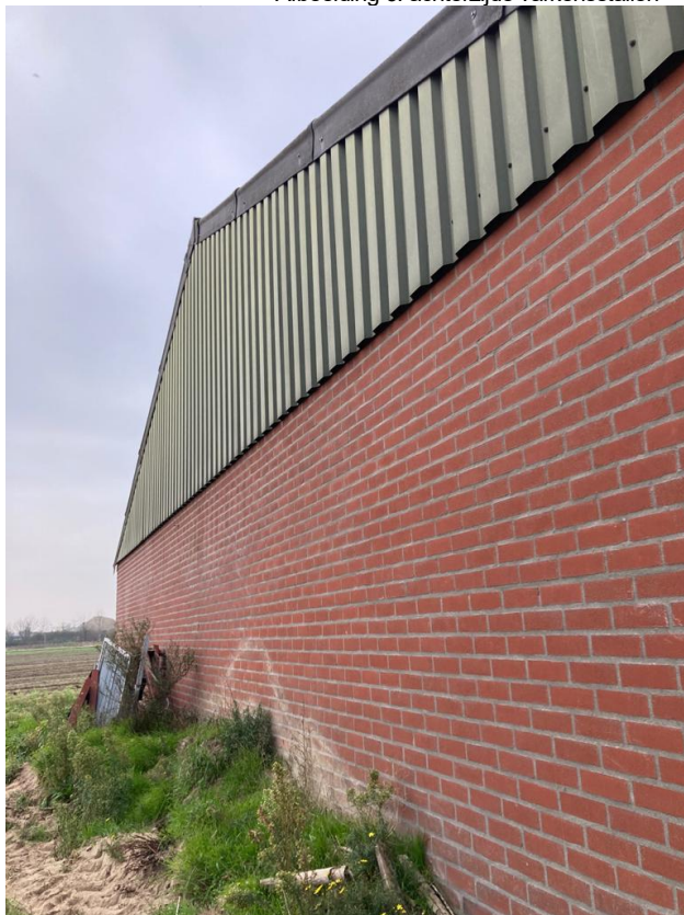
• Afbeelding 6: achterzijde varkensstallen
