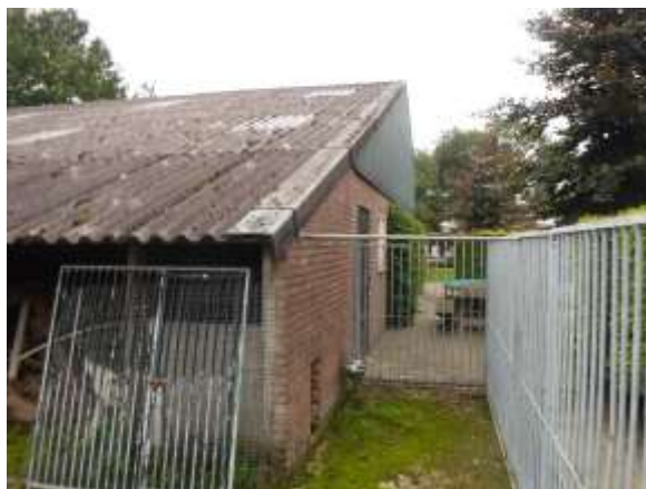
Schuur 2: golfplaten dakbedekking.
