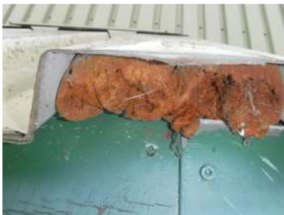
Afdichting openingen damwand gevels.
