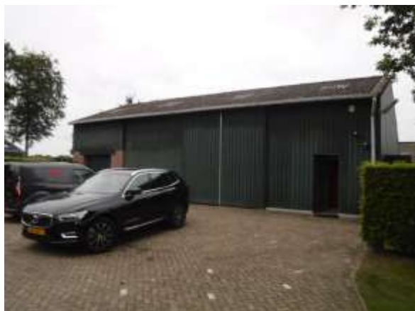
Schuur 1: golfplaten dakbedekking.
