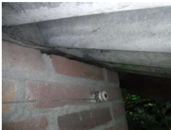
Afdichting gaten met cement schuur 2.
