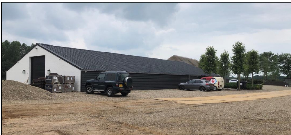
Figuur 5: Voormalige rundveestal gerenoveerd tot paardenstal met rijbak
