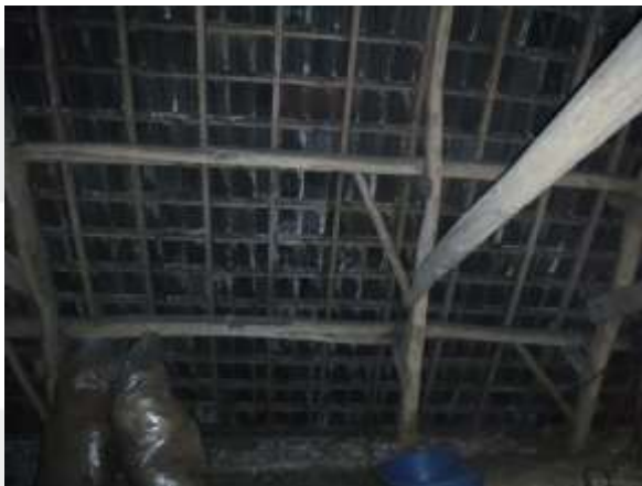
dakconstructie en zolderruimte voormalig stalgedeelte boerderij geïnspecteerd.
