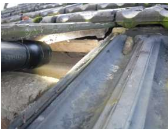
Inspectie onder pannen boerderij.
