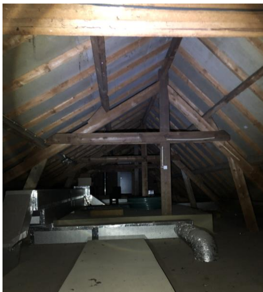
Figuur 5: Zolder 2 gebouw B.
