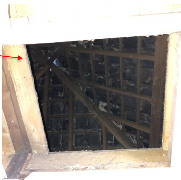
Figuur 4: Zolder 1, gebouw A.
