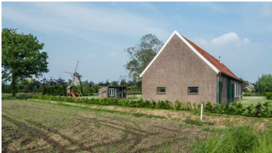
Figuur 23: Zicht vanaf de Schutsstraat op de molen aan de Molendreef, met aan de rechterzijde de huidige woning aan de Schutsstraat 34
