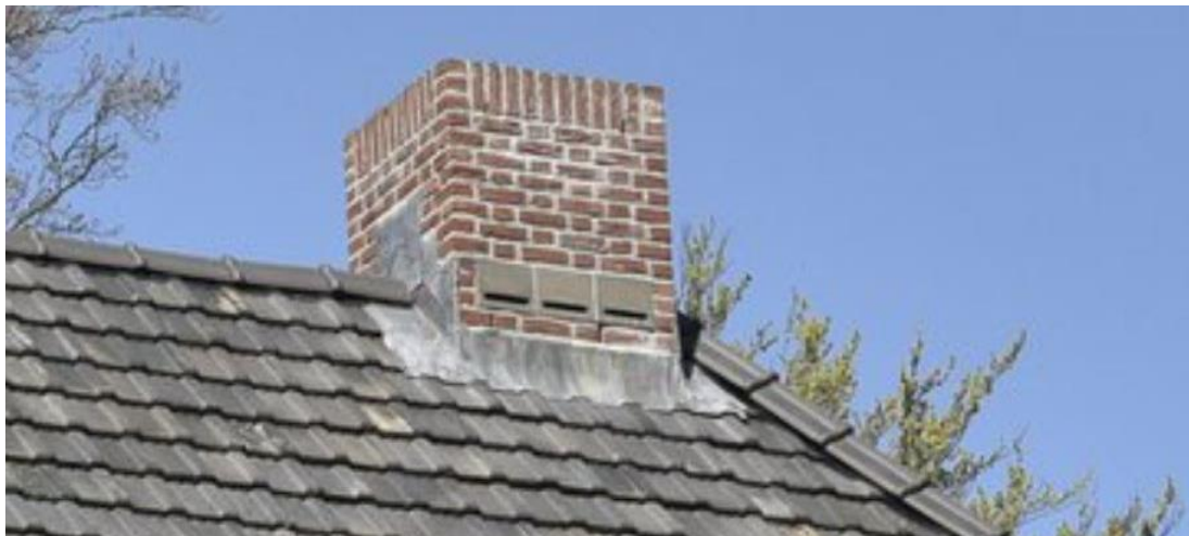
Voorbeeld van een schoorsteen met ingebouwde vleermuiskasten.
